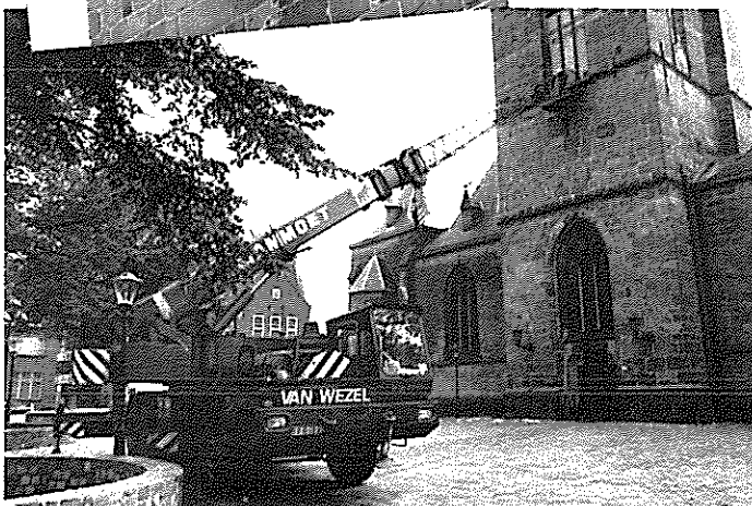
Restauratiewerk aan een kerktoeren met behulp van een 20-tons hydraulische kraan
