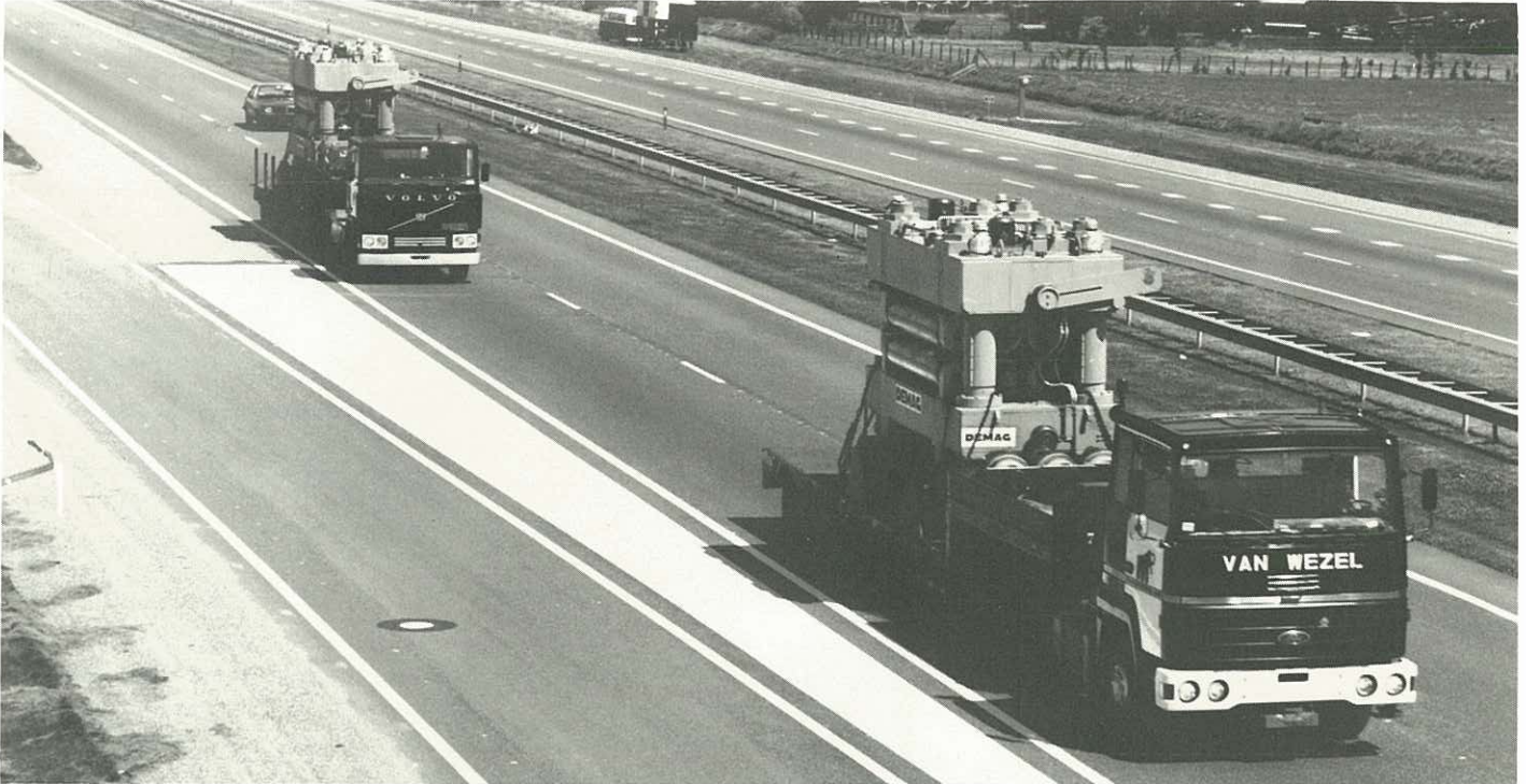
Transport van 50 ton wegende plaatwalsen op 5-assige semi-diepladers van Düsseldorf naar IJmuiden
